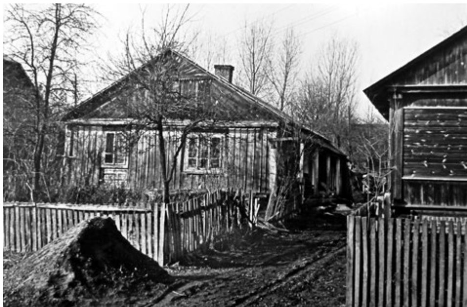
Dom rodzinny Dominika Wośki około 1990 roku. Pokrycie dachu ze słomy zostało wymienione, natomiast cała konstrukcja budynku pozostała nienaruszona. Dom został rozebrany na początku XXI wieku. Fot. ze zbiorów Tadeusza Surdackiego
